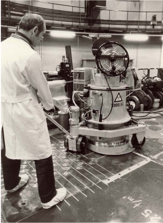
Billede 5. En færdigbestrålet siliciumkrystal flyttes i en blyafskærmet "flaske" fra det forsøgsrør i DR 3, hvori den er blevet bestrålet til lagerområdet, hvor den skal stå til "afkøling" i en uges tid. Herefter er strålingsniveauet så lavt, at krystallerne kan håndteres med de bare hænder. I reaktoroperatørernes jargon gik siliciumflasken under navnet "den røde tyr", fordi den var så vanskelig at styre! Foto fra sidst i 1970'erne. Risøs Billedarkiv.
